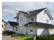
STEIL- UND FLACH- DACHARBEITEN
