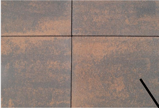
Betongroßplatten 60/60/12 cm, Klostermann Scada, braun-schwarz nuanciert
