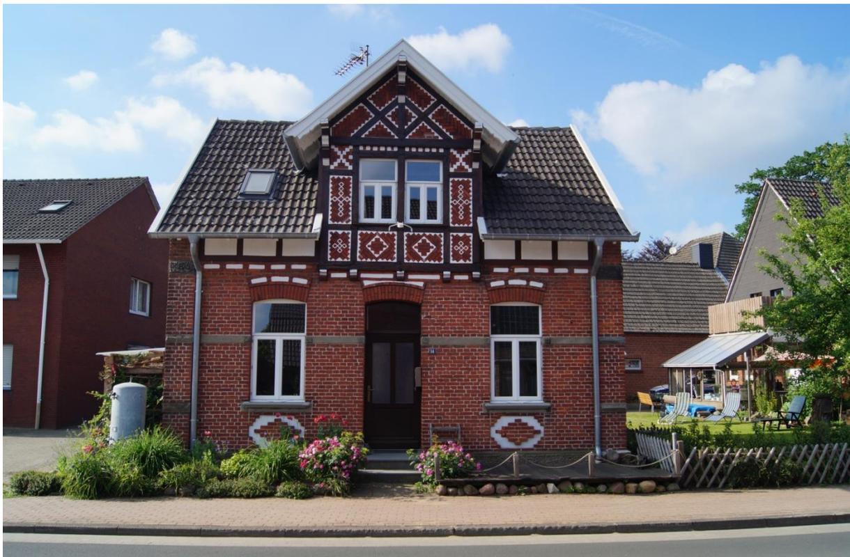
Abbildung 37: Privatmaßnahme Körbe – Fassadensanierung, Austausch von Fenstern und Türen, Arbeiten am Dach und den Windfedern
