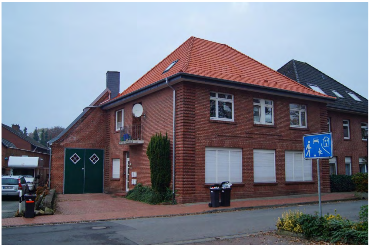
Abbildung 23: Privatmaßnahme am Lindenbrink 3 – Dachsanierung
