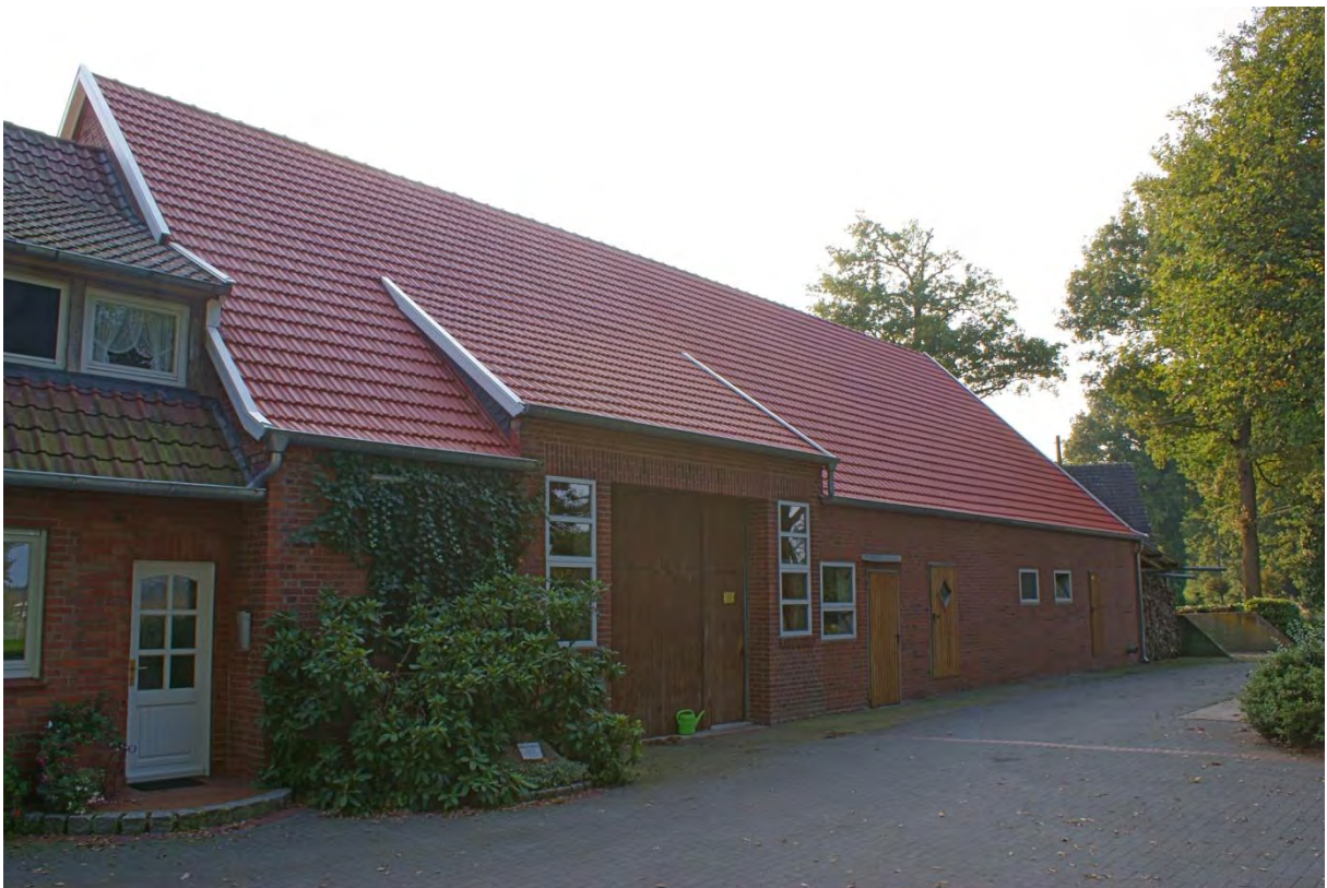
Abbildung 21: Privatmaßnahme Roling – Dachsanierung und Erneuerung von Toren und Türen
