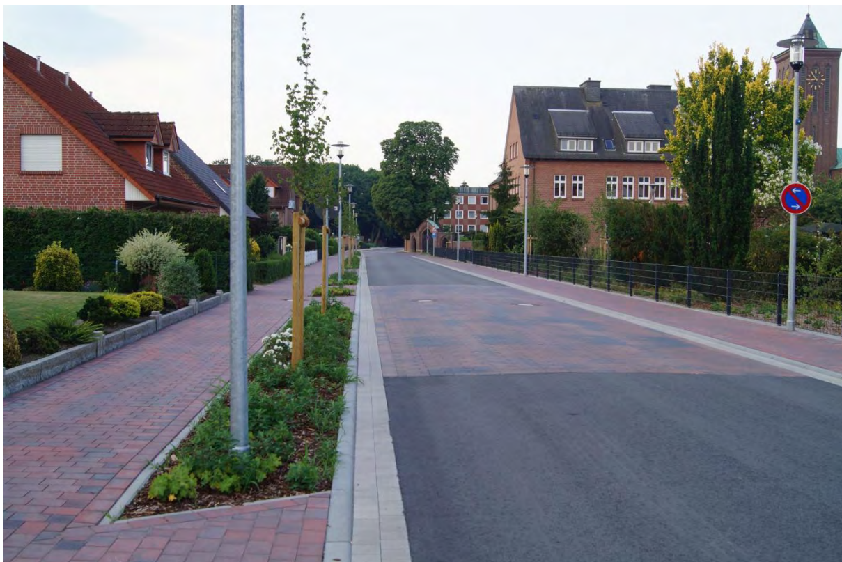
Abbildung 7: Blick entlang der fertiggestellten Achse der Klosterstraße mit Blickrichtung BBS
