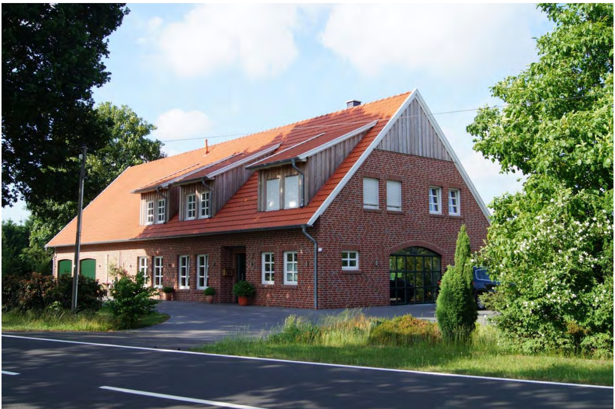
Abbildung 19: Privatmaßnahme Geerdes – Sanierung einer ehemaligen landwirtschaftlichen Hofstelle
