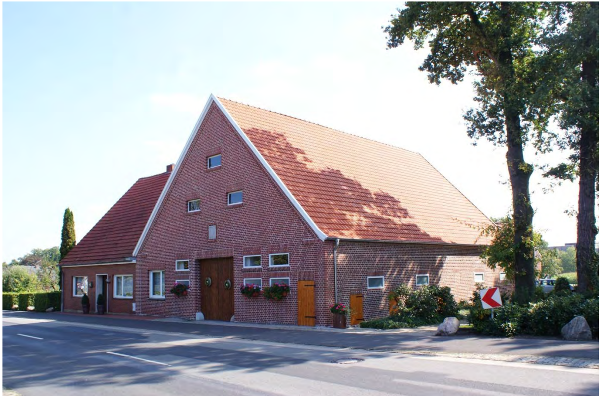
Abbildung 22: Privatmaßnahme Manze – Dach- und Fassadensanierung
