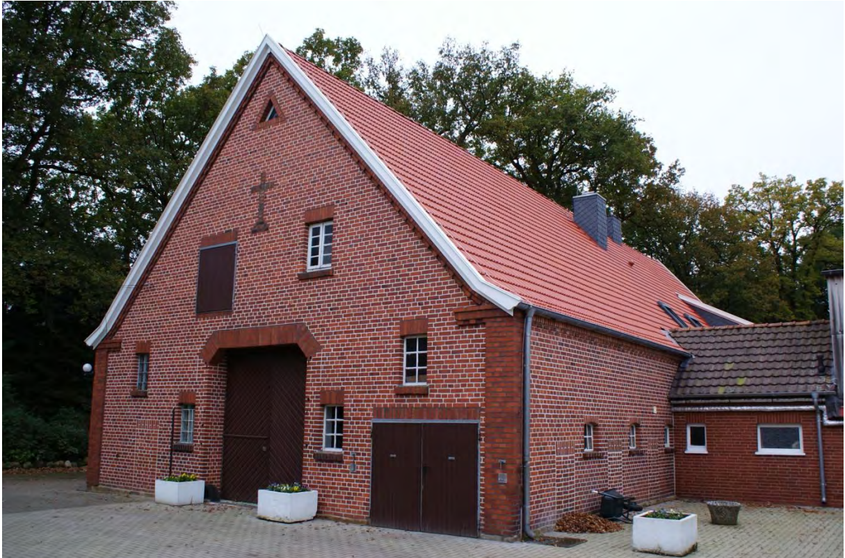
Abbildung 20: Privatmaßnahme Heitker – Dachsanierung
