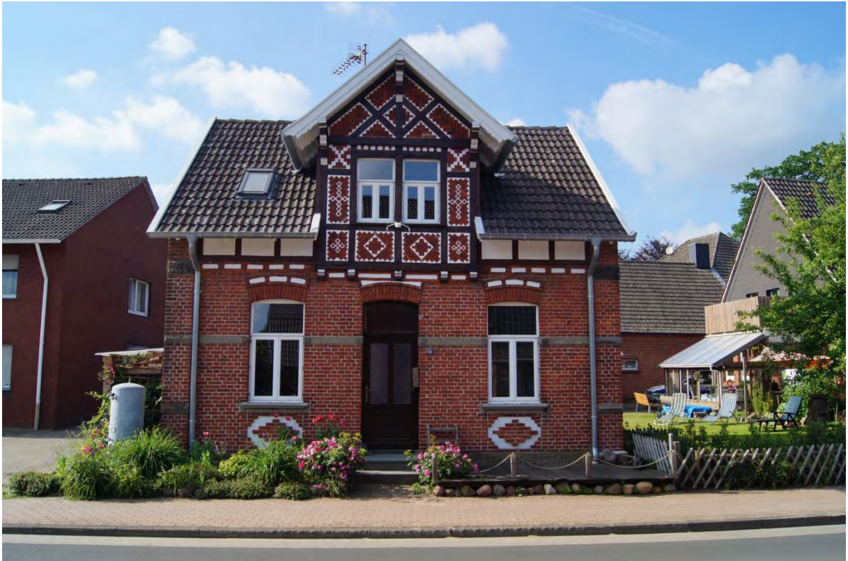
Abbildung 18: Privatmaßnahme Körbe – Fassadensanierung, Austausch von Fenstern und Türen, Arbeiten am Dach und den Windfedern
