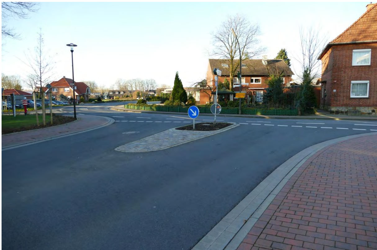
Abbildung 4: Blick auf den fertiggestellten Mündungsbereich Hauptstraße / Klosterstraße
