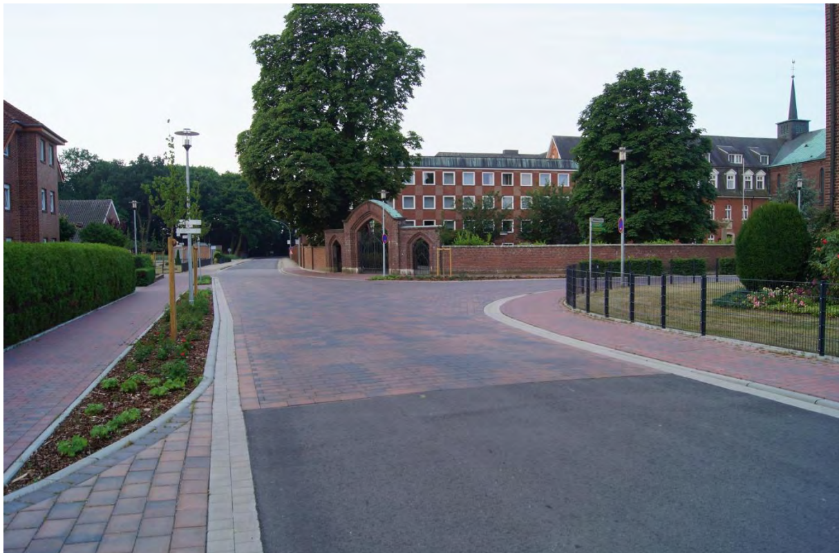
Abbildung 8: Blick auf den fertiggestellten Kreuzungsbereich Klosterstraße / Mühlenstraße / Gerhard-Dall-Straße
